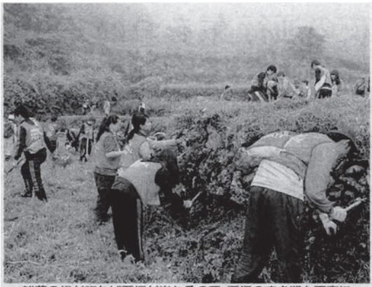
雑草の根が張れば石垣が崩れるので、石垣のすき間も丁寧に草刈りする参加者＝唐津市相知町の蕨野の棚田
