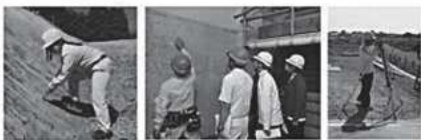
工事現場での研修 （左）地盤の強度計測 （中）耐震改修現場 （右）測量実習
