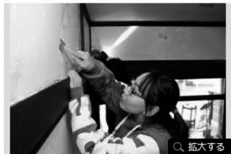
しつくいを塗り直すため、表面のペンキを削り取っていくボランティアたち＝佐賀市松原の松川屋
