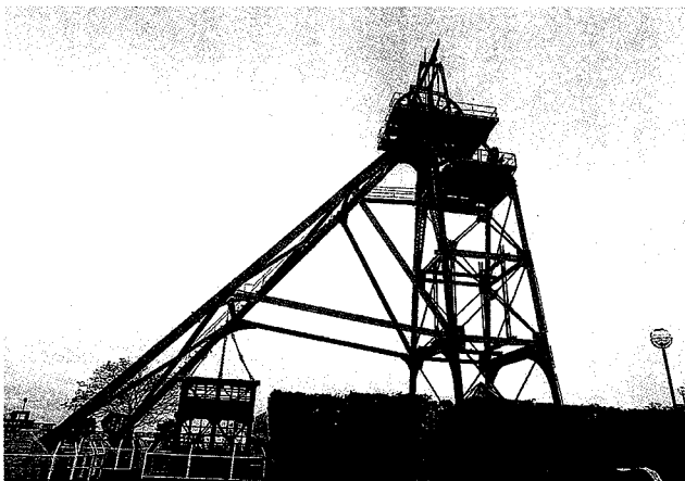
旧三井田川鉱業所 伊田竪坑櫓
