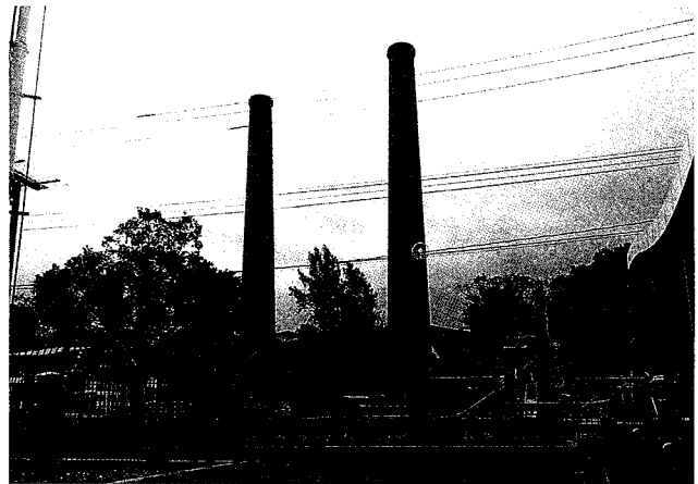
旧三井田川鉱業所 伊田竪坑 第一・第二煙突
