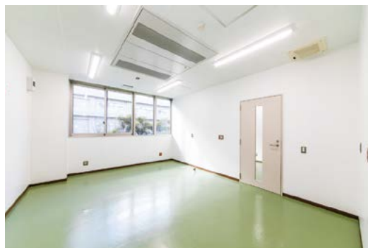
LED照明器具の導入 （2024年度 院生・臨床研究棟（Ⅲ期）実験研究室）
