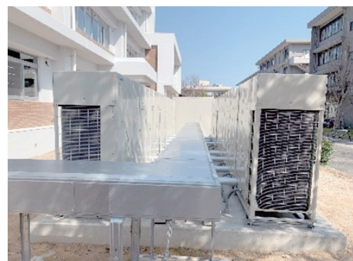
高効率空調機へ改修した建物 （2020年度 理工学部4号館 室外機置き場）
