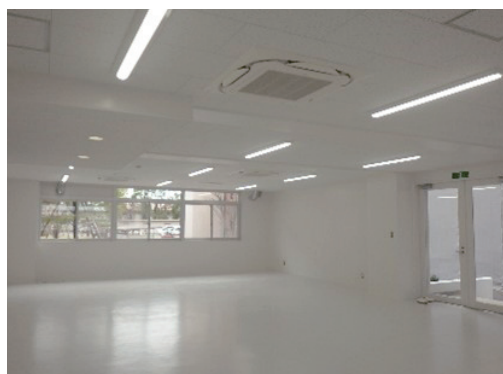
LED照明器具へ改修した建物 （2020年度 理工学部4号館 101室）
