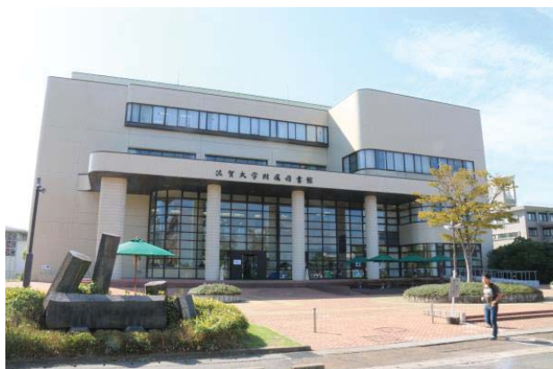
附属図書館 本館
