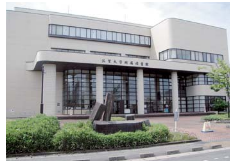
附属図書館本館
