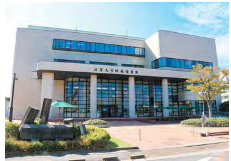
附属図書館本館
