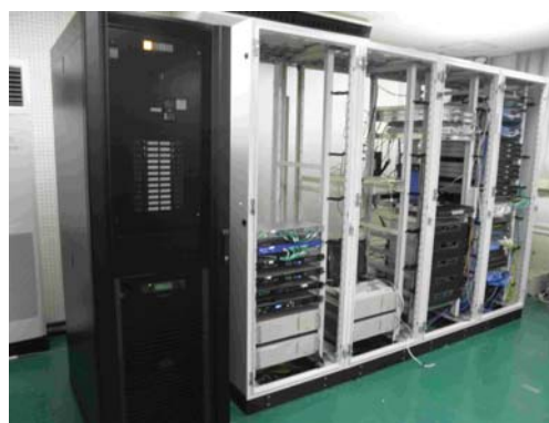
図 4.9: 新キャンパス情報ネットワークシステムのラック配置。一番左が無停電電源装置
