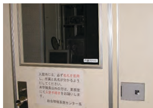
図 4.6 コンピュータ室入口の入退室管理
