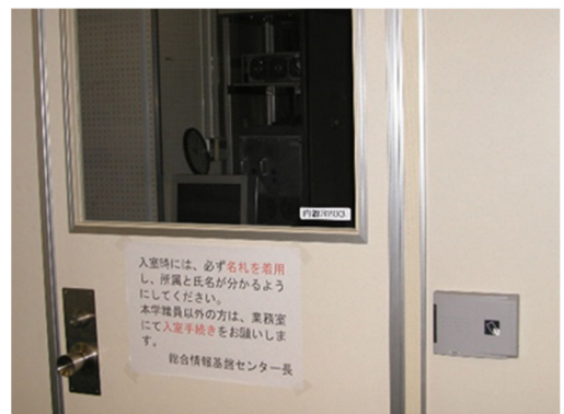
図 4.6 コンピュータ室入口の入退室管理
