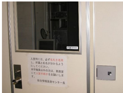
図 4.6 コンピュータ室入口の入退室管理
