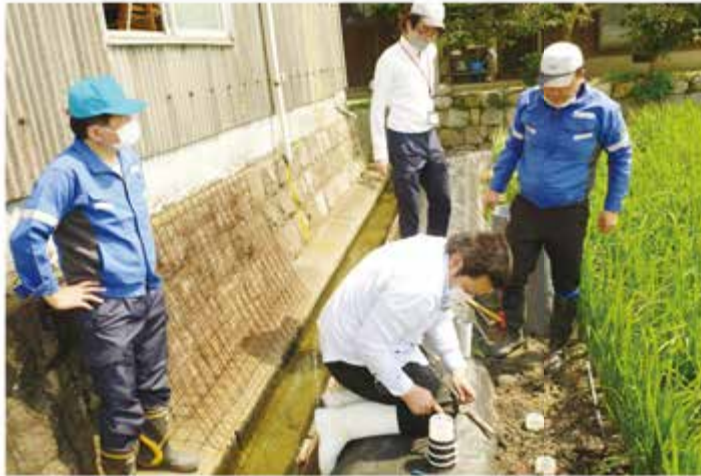
水田に電極の装置を設置している様子
