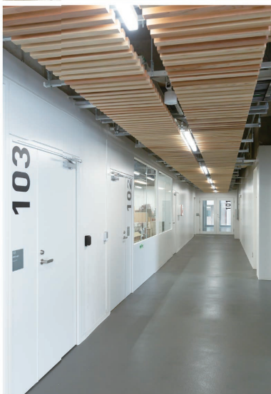
さまざまな建材にサインをつけて建材の名前が分かるようになっている。天井には木材を並べて柔らかなニュアンスを出す一方で、配管の様子も見える
