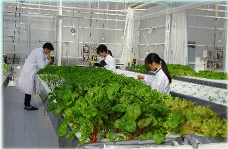
本庄キャンパスに設置された太陽光利用型植物工場
